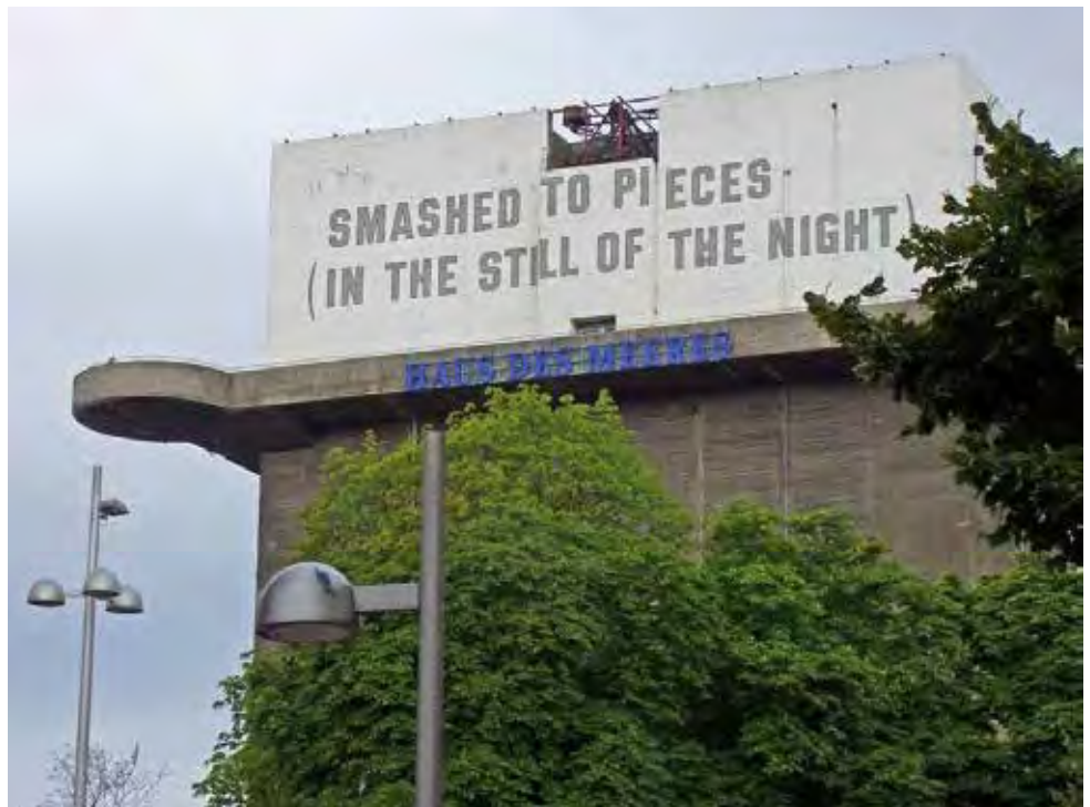
Abb. 10 Außenansicht Haus des Meeres 2018
